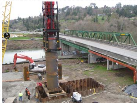
Δοκιμή Φόρτισης Πασσάλου διαμέτρου 2.8m
